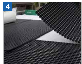
4 *Drän- und Speicherplatte 20 mm Platten ca. 1,06 x 2,36 m
