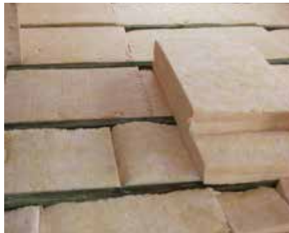
Bei Blindboden, vorbereitet für Dämmung. Machen Sie das Haus von unten winterfest. Aufpreis für kesselhochdruckimprägnierter Blindboden: wird nur bei Erstellung von Streifenfundamenten benötigt, wenn Isomaterial in den Fußboden eingebracht werden soll
