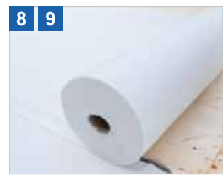
8) Erste Lage Vlies - 9) 22,5 x 96 mm Faserbretter Holzschalungsfläche
