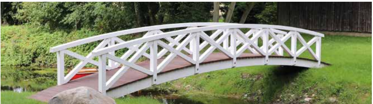
Individuelle Brücken durch Joda® geplant und umgesetzt
