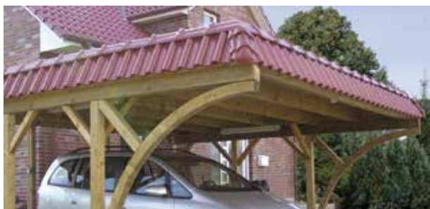
Breite Einfahrt: Pfostenbögen aus Leimholz
