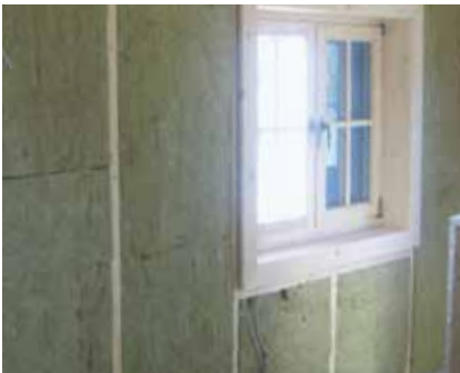
„Winterfest-Option“: doppelschalige Außenwand mit innenliegender Dämmung. Aufpreis für doppelschalige Außenwände: Verschiebesystem und ca. 18 mm Nut- und Federbretter inkl. Befestigungsmaterial und breiteren Tür- und Fensterfutterahmen; geeignet für Einbringung von ca. 100 mm Dämmmaterial
